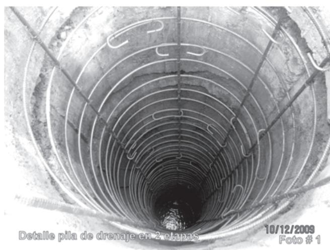
Figura 5 - Detalle de pila de drenaje en 2 etapas.
