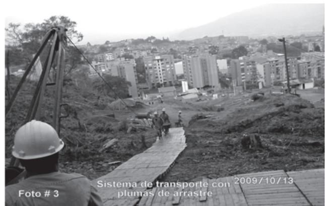
Figura 8 - Sistema de transporte con plumas de arrastre
