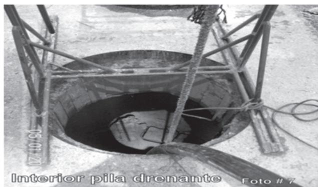
Figura 11 - Interior de una pila drenante
