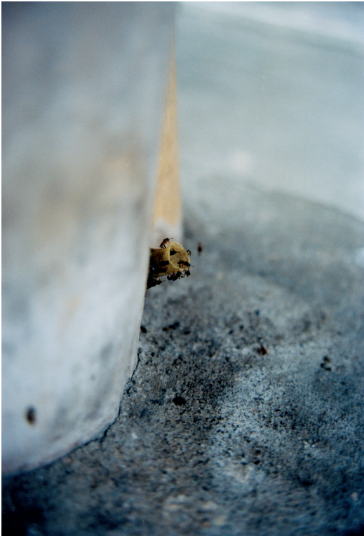
Pérgola acceso bloque Humanitas.
