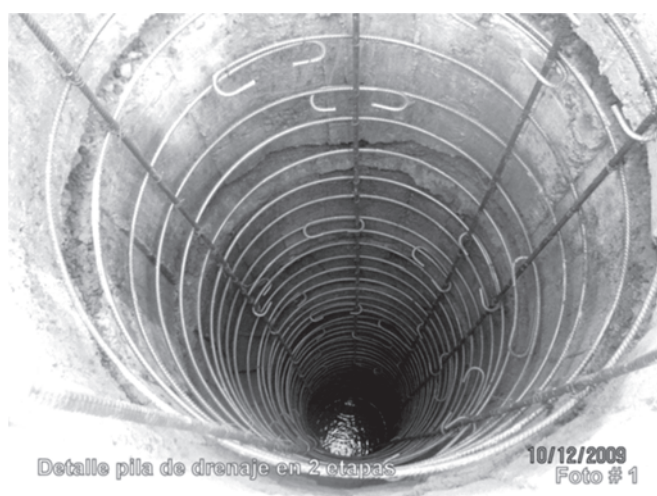
Figura 5 - Detalle de pila de drenaje en 2 etapas.
