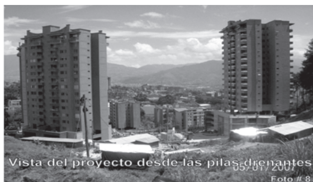
Figura 12 - Vista del proyecto desde las pilas drenantes
