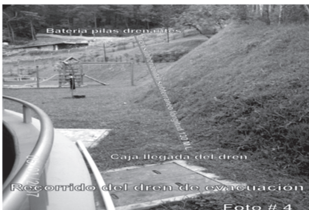
Figura 9 - Recorrido del dren de evacuación
