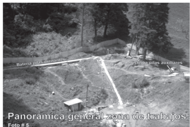
Figura 9 - Panorámica general de la zona de trabajos
