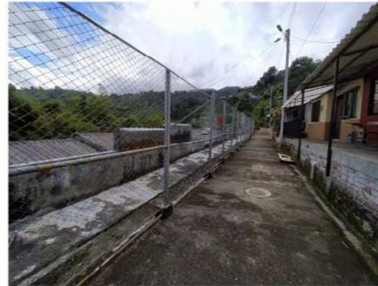
Acceso peatonal descubierto manzana 44
