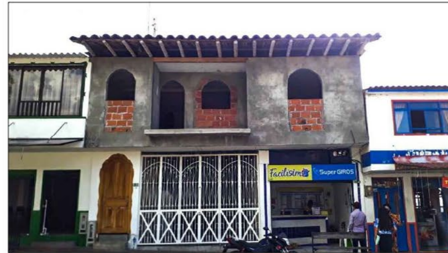
Vivienda en construcción | Súper Giros
