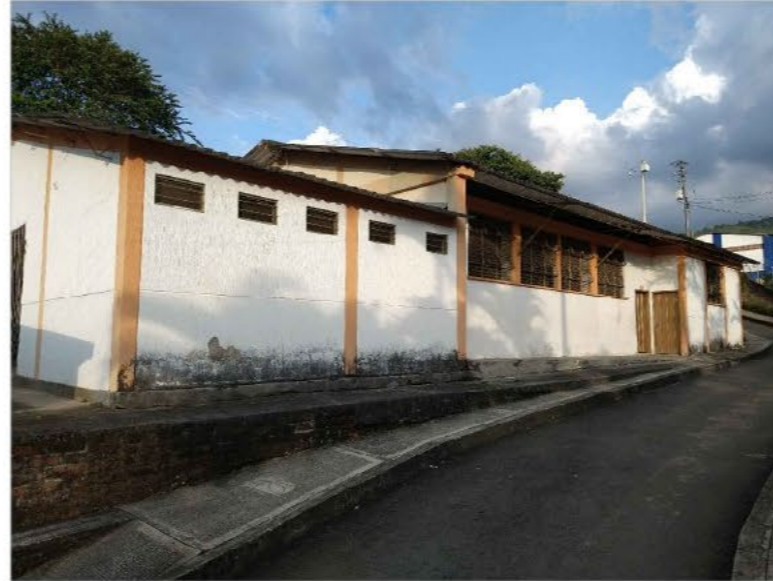
Fachadas Centro de Nutrición (ICBF)
