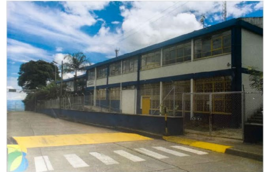
Fachada Instituto Buenavista (Bloque Primaria)
