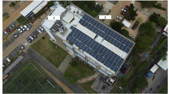
Fig. 2. Planta fotovoltaica de estudio.
