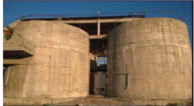
Fig.1. Fermentador MTPR (Concrete). Expuesto a intemperie.
