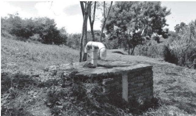
Fig. 8. Fotografía de un pozo de biogás de relleno sanitario.
