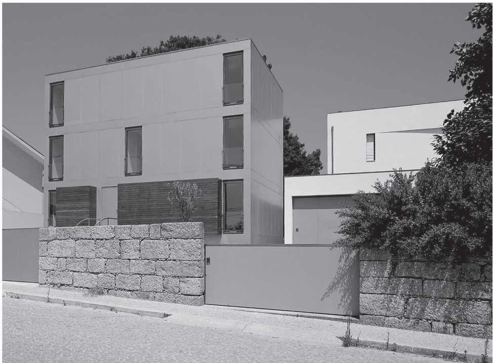
Casa En Lugar Da Várzea | Vermoim - Maia Proyecto – 1996 / 1997 Obra – 1999 / 2001
