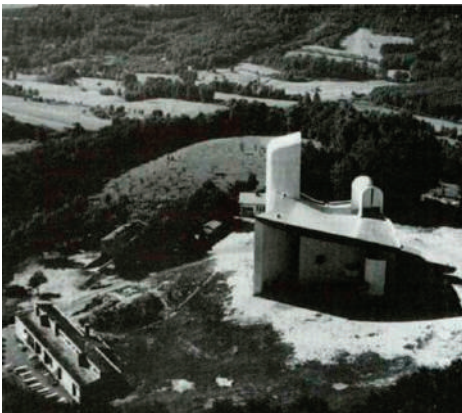
Figura 10. Vista hacia el oeste: frondas de árboles próximas a la colina (Pauly, 1980)
